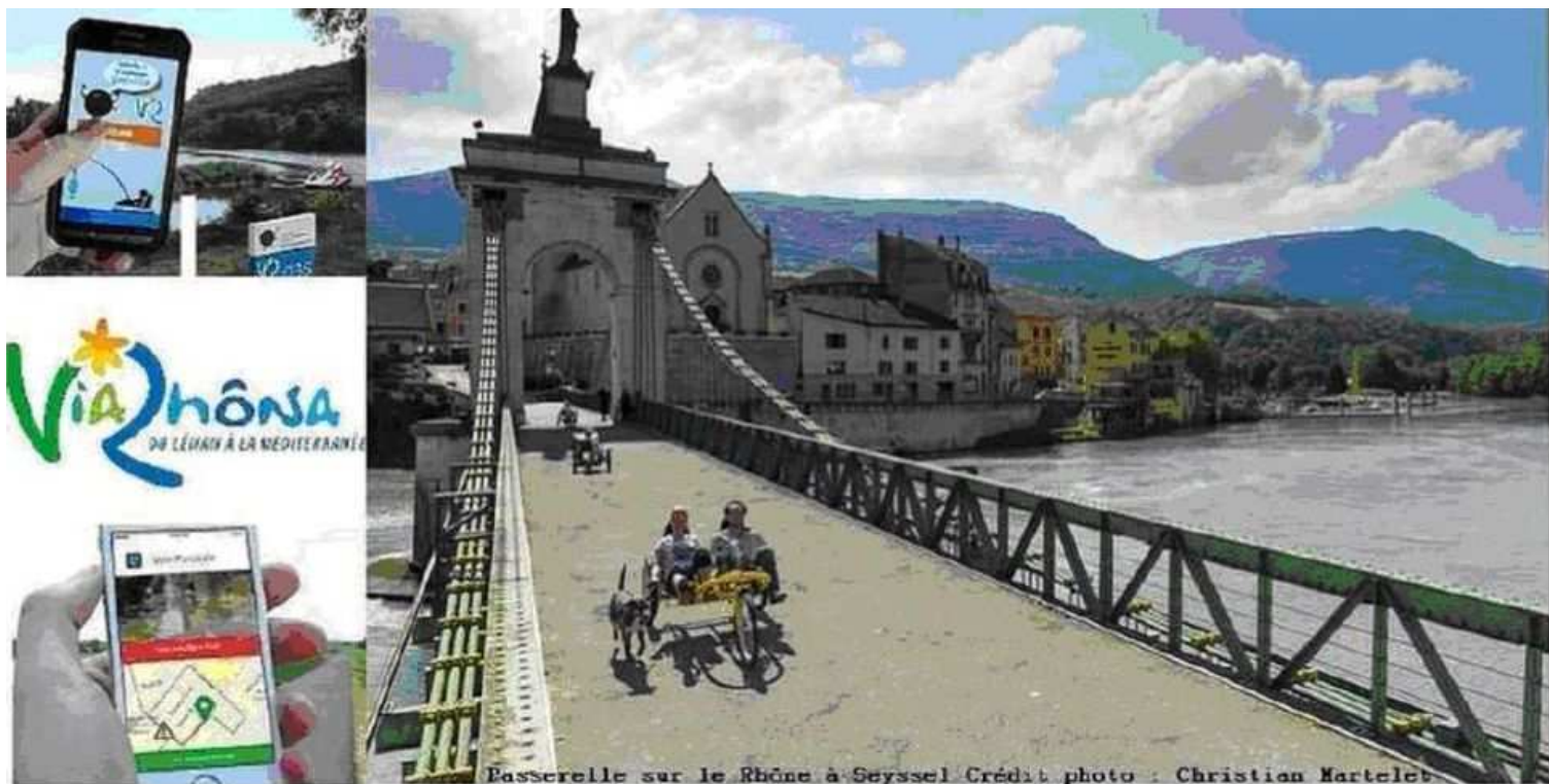
Passerelle sur le Rhône à Seyssel Crédit photo : Christian Martelet
